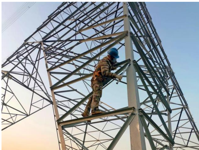
图 1.2 现有人工接触式输电铁塔螺栓紧固状态巡检
